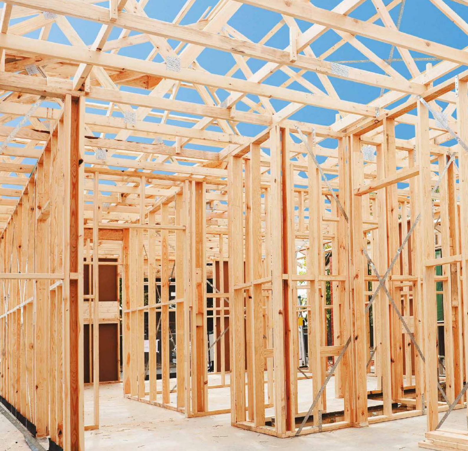
Dettaglio di una casa in costruzione. A house under construction. Détail d'une maison en construction. Detalle de una casa en construcción.
